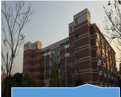
土建系教学楼
